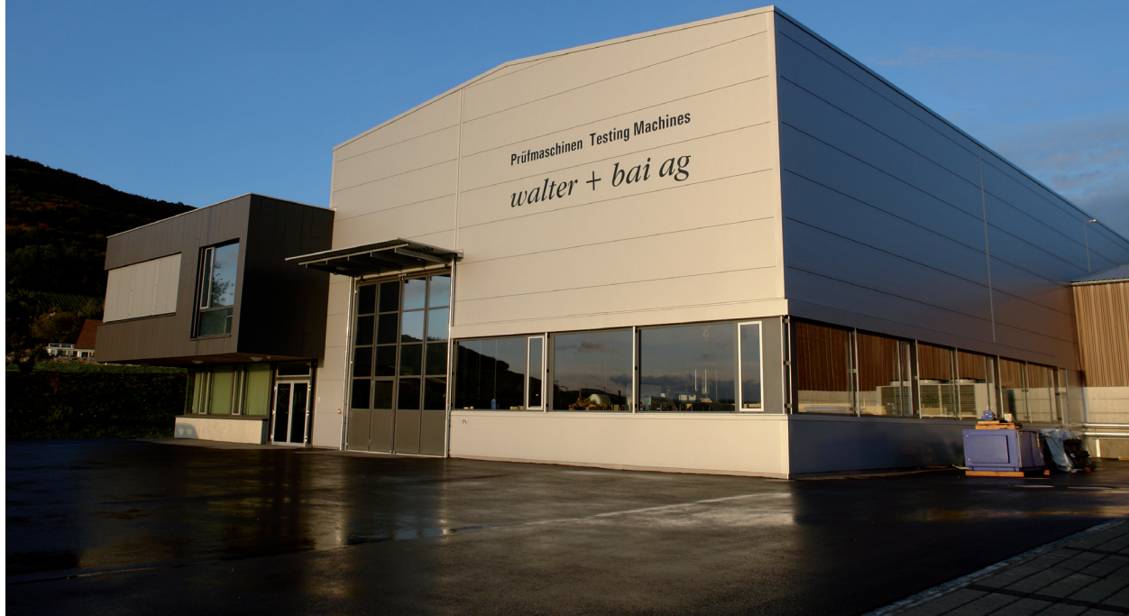
Vista del edificio de w+b, con el ala de montaje en primer plano y edificio de oficinas al fondo, en Löhningen, Suiza.
