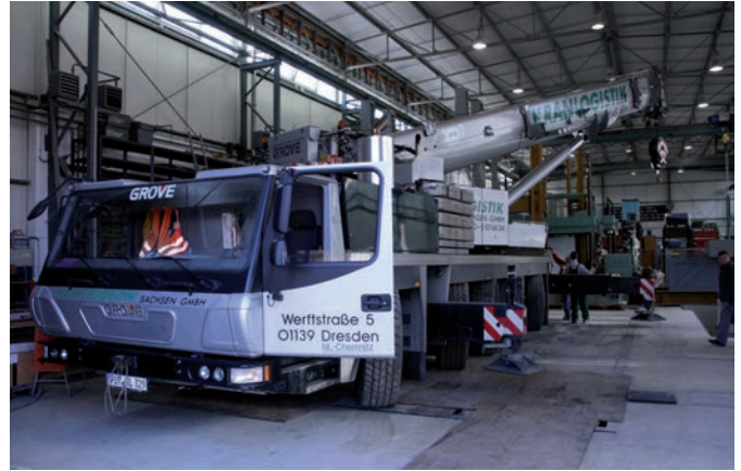
a) Autokran für die Montage
