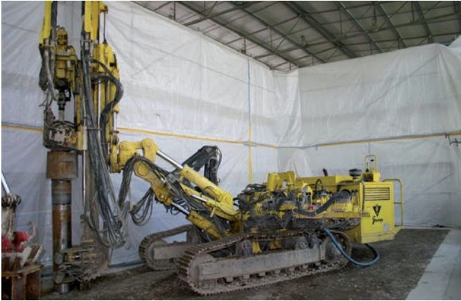
a) Einbringen der Bohrpfähle
