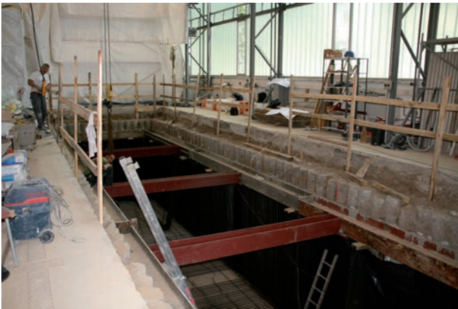
b) Aussteifung der Baugrube
